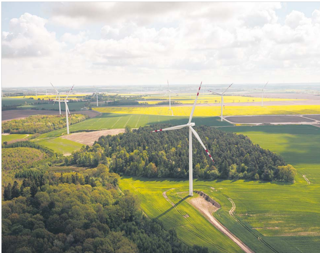
Udział odnawialnych źródeł energii wzrośnie istotnie wraz z oddaniem morskich farm wiatrowych, które obecnie są w budowie
