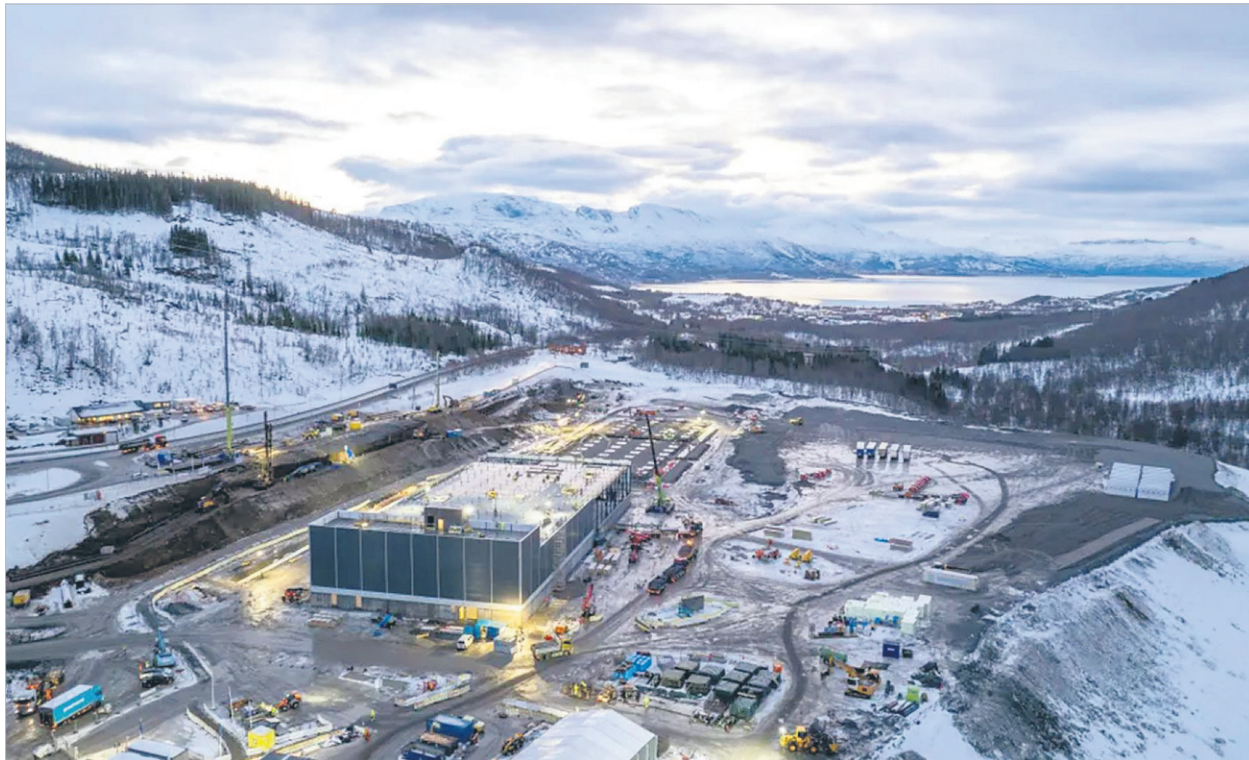
Europa buduje gigafabryki, żeby zwiększyć własną suwerenność technologiczną i geopolityczną. Na zdjęciu: projekt Stargate Norway w Narwiku realizowany przez firmy Nscale i Aker. Ma dysponować 230 MW mocy obliczeniowej
