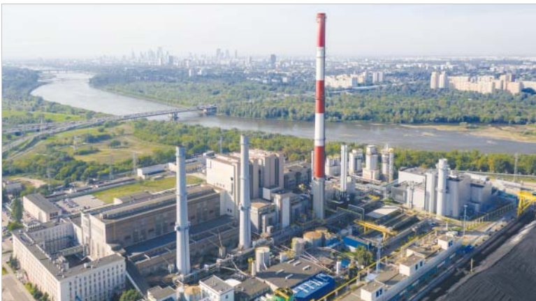
Elektrociepłownia Żerań w Warszawie należąca do ORLEN Termika
