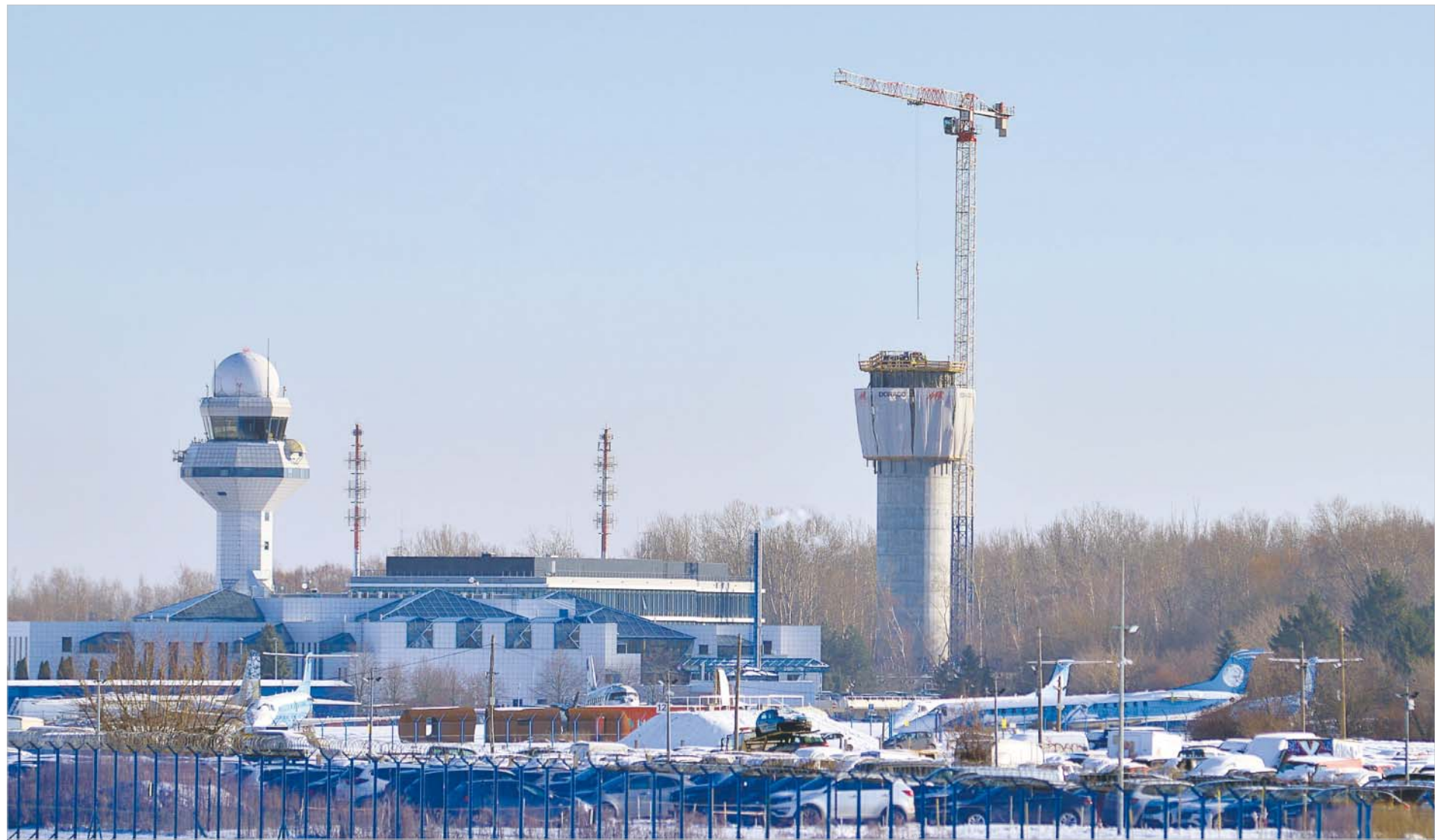
PAŻP buduje nową wieżę kontroli ruchu lotniczego w Warszawie, która ma obsługiwać ruch Lotniska Chopina i być wyposażona w nowe rozwiązania technologiczne
