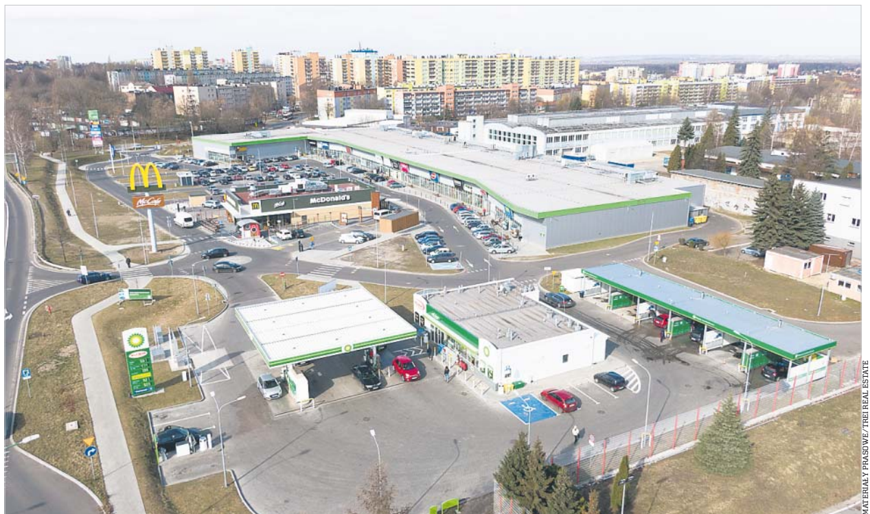
Wszystkie oddane w I kwartale obiekty handlowe i gros tych w budowie to parki
