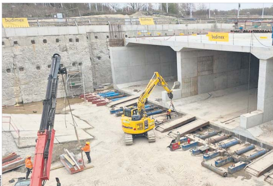
GDDKiA rozpoczęła przeciskanie ważącego ponad 5,5 tys. ton betonowego prostopadłościanu pod torami kolejowymi w Oświęcimiu w ramach budowy nowej drogi krajowej nr 44
