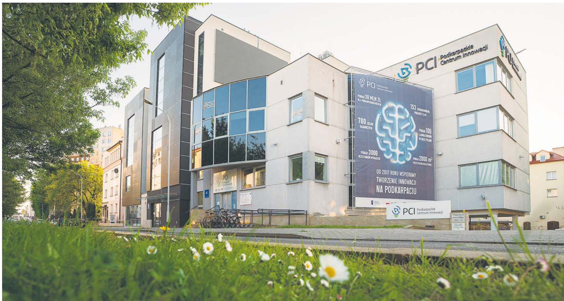
Siedziba Podkarpackiego Centrum Innowacji
