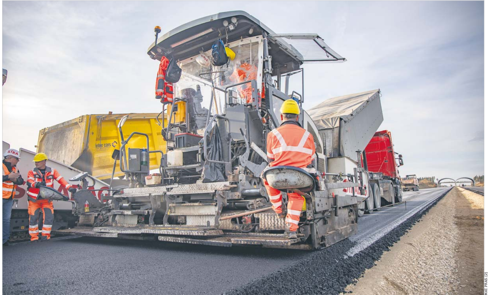
Nawierzchnia asfaltowa w technologii spienionej pozwala na ograniczenie emisji i obniżenie śladu środowiskowego budowy dróg, jest także trwalsza od tradycyjnej
