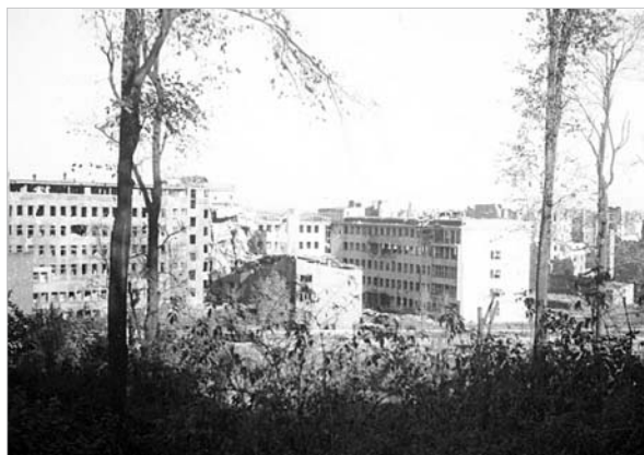
Zniszczona siedziba ZUS przy ul. Czerniakowskiej 231, sierpień 1944 roku. W centrali pozostała jedynie niewielka grupa, aby utrzymać łączność ze Śródmieściem
