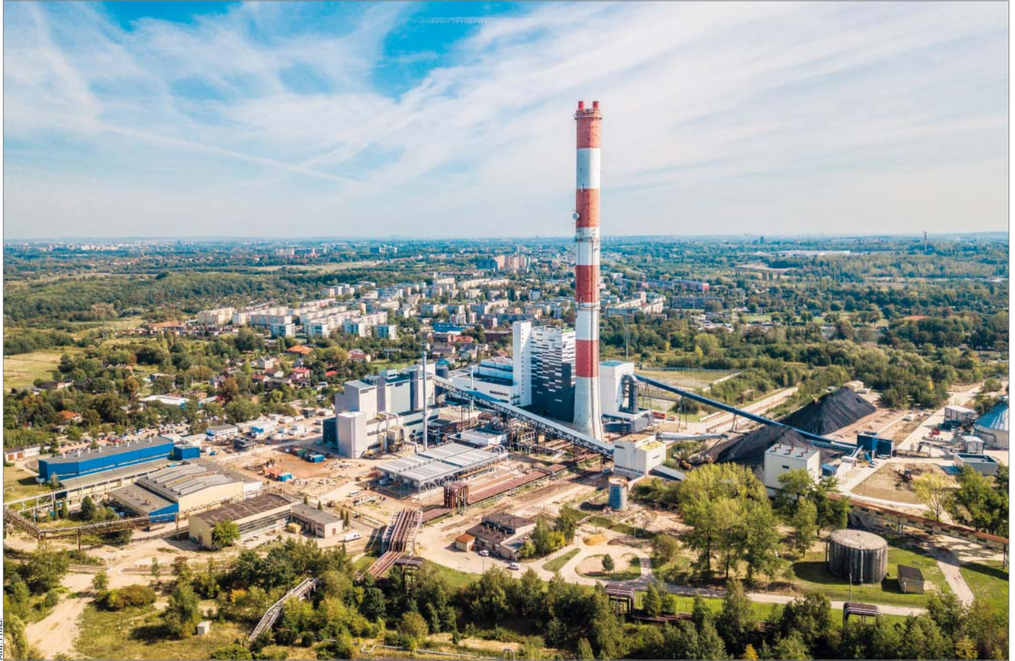
♦ Elektrociepłownia Zabrze – otwarta w zeszłym roku najnowocześniejsza europejska elektrociepłownia Fortum – jest praktycznym przykładem wdrażania gospodarki obiegu zamkniętego
